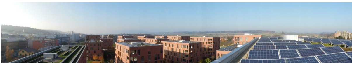
L'installation Ruggächern, répartie sur plusieurs toits
